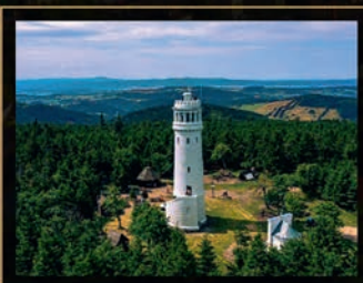
Remont wieży widokowej na Wielkiej Sowie
